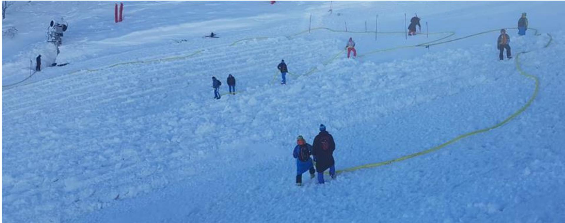
С помощью отвала нарезаются борозды, после заливки водой (заливать необходимо обязательно с помощью хороших насадок рассеивающих воду), ратрак только с помощью гусениц выравнивает склон, уплотняя (утапывая) борозды, а затем под фрезу.
